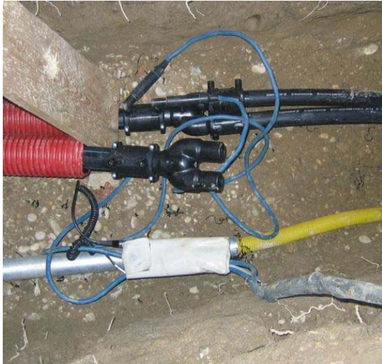
Slika 7. a) Elektrofuzijsko zavarivanje toplinske sonde s polaznom i povratnom cijevi; b) Uvođenje temperaturne i toplinske sonde u zgradu laboratorija
